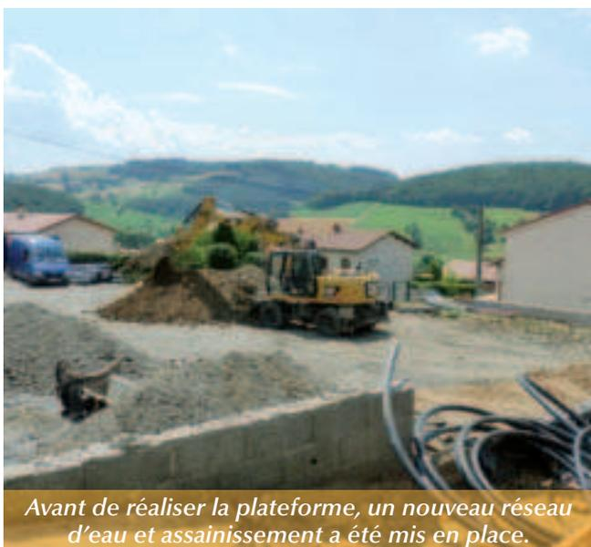
Avant de réaliser la plateforme, un nouveau réseau d'eau et assainissement a été mis en place.
