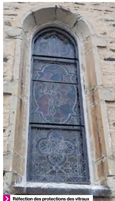
➤ Réfection des protections des vitraux
