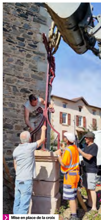
➤ Mise en place de la croix
