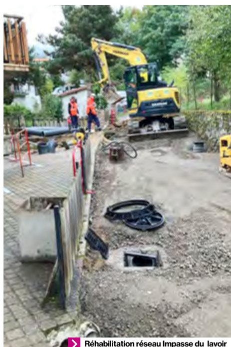
➤ Réhabilitation réseau Impasse du Lavoir
